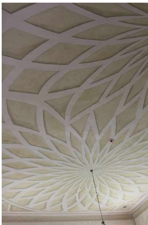
Teil der Kirchendecke
